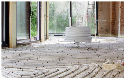
Le tuyau multicouche Alupex avec couche en aluminium soudé bout à bout présente la meilleure barrière anti-oxygène, conserve sa forme et est facile à installer. Offre un bon transfert de chaleur et une dilatation minimale grâce à sa couche en aluminium. Vous pouvez toujours utiliser toutes les chutes d'Alupex comme tuyaux en sanitaire et chauffage central. Ces chutes déterminent en grande partie le rendement de votre chantier.
