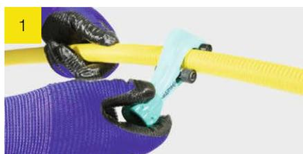
Couper le tuyau PLT Paktermo à l'aide du coupe tube fournis par le fabricant. Couper à travers la gaine synthétique et le tube en acier inoxydable avec un coupe-tube à molette en acier tranchant. Couper le tube en creux d'onde puis faire tourner la coupe tube dans une seule direction en resserrant la molette de pression progressivement après chaque rotation. Ne pas serrer trop fort le coupe-tube sinon vous risquez de déformer l'extrémité du tuyau.
