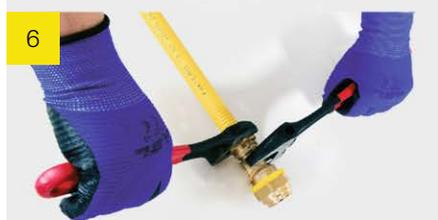
Ensuite, serrez l'écrou à l'aide d'une deuxième clé. Appliquer la couple de serrage comme indiqué dans le tableau 4.
