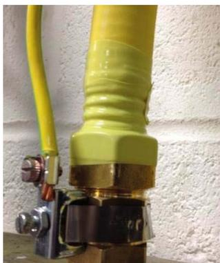
Un tuyau PLT enterré doit être isolé galvaniquement du tuyau métallique hors sol, ou du tuyau à l'intérieur du bâtiment à l'aide de joints isolants ou de brides isolées. Cette isolation s'effectue hors sol, à maximum 50 cm du niveau du sol ou lors de la pénétration dans un bâtiment.
