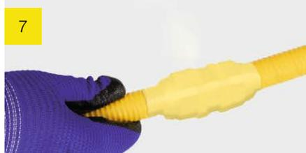
Le revêtement de protection supprimé lors du montage doit être reconstitué par l'emploi des bandes autovulcanisante Paktermo.
